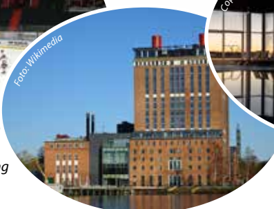
Steam Hotel Västerås
