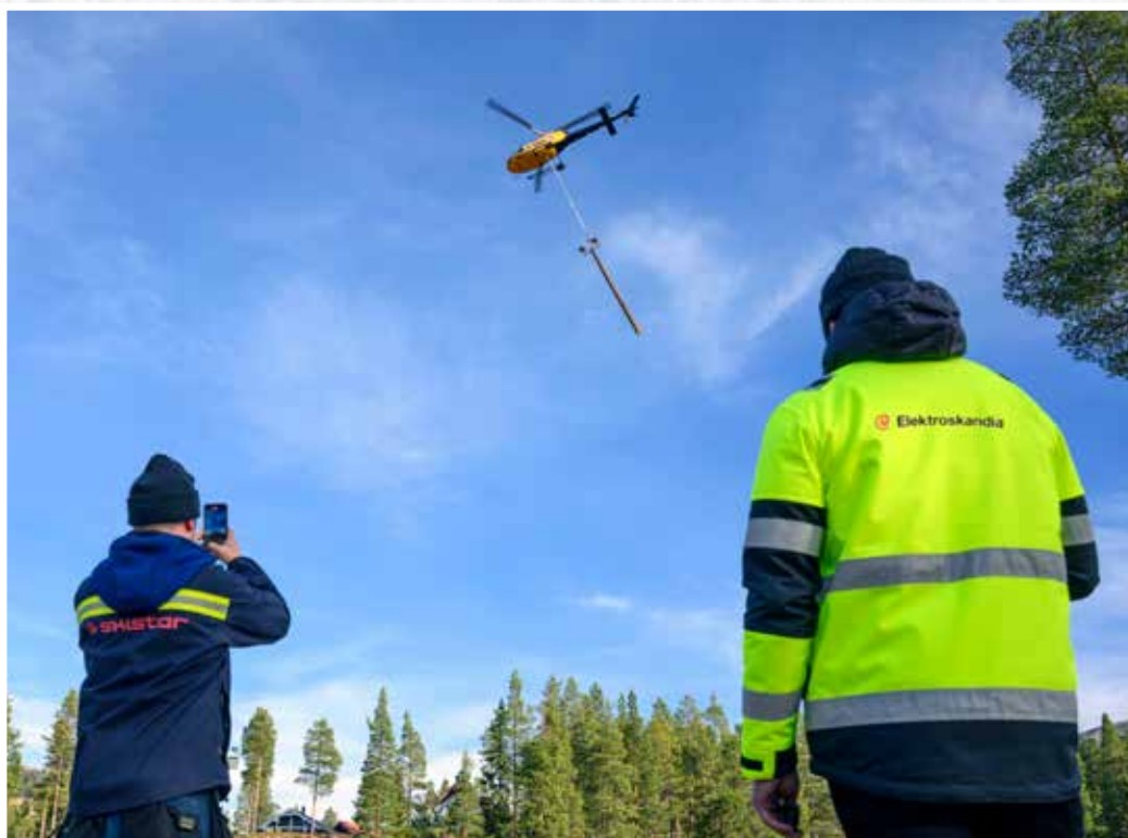
Stolparna med de nya strålkastarna monterade lyftes snabbt på plats med helikopter.
